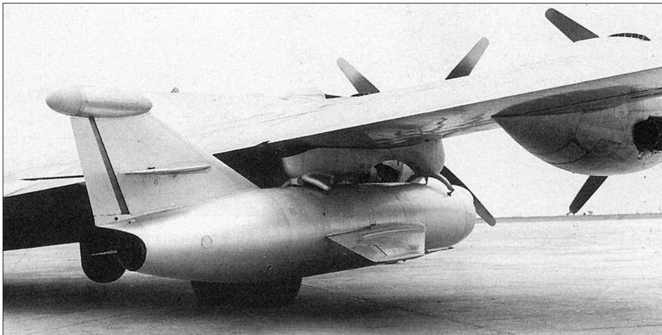
«Комета» на балочном держателе самолета Ту-4К. Под фюзеляжем самолета видна выпущенная антенна РЛС в обтекателе
