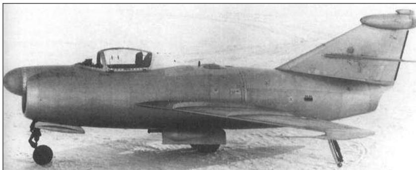
Пилотируемый самолет-аналог «К» служил для отработки систем будущей крылатой ракеты
