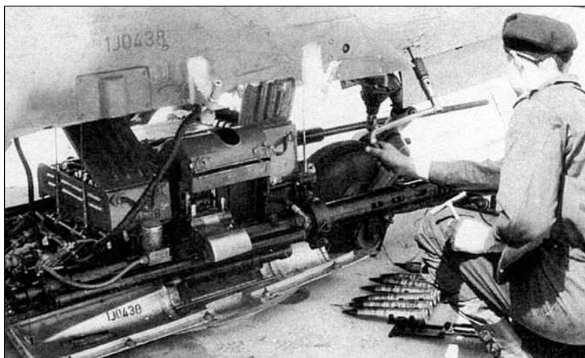
Все оружие МиГ-17, как и на его предшественнике располагалось на опускаемом лафете
