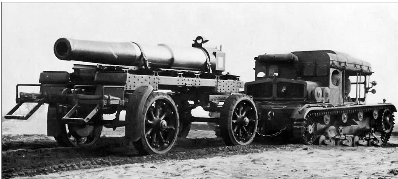
Тягач С7Р, выпускавшийся на базе танка 7ТР, использовался для буксировки 220-мм мортиры
