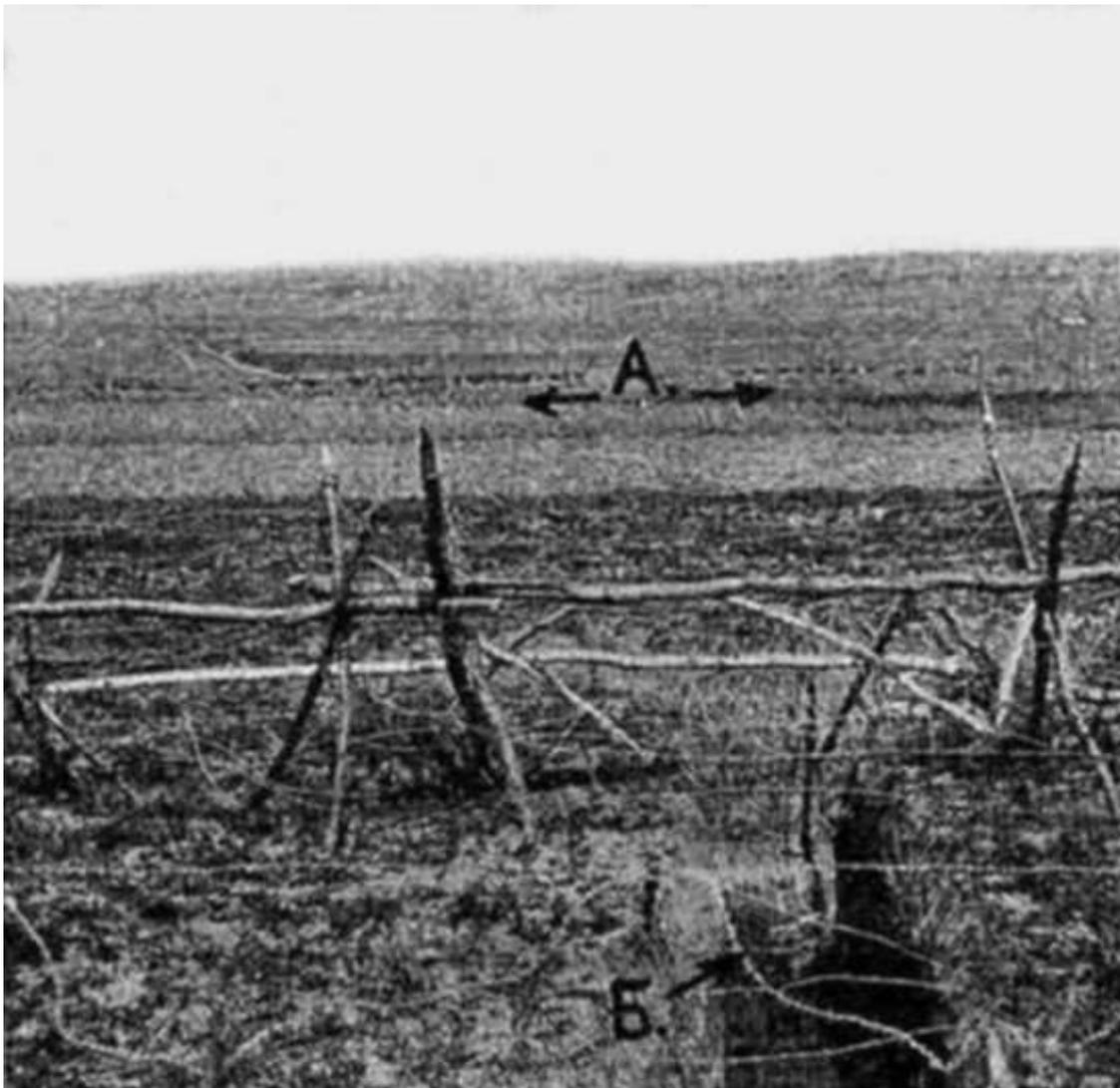
Рис. 1. А – русский окоп, с ясно видимыми даже на фотографии, бойницами, которые – со дна рва Б проектировались на фоне неба. Б – проход из-под бруствера австрийского окопа в сторожевой (снайперовский) ровик. Снято с бруствера австрийского окопа.
