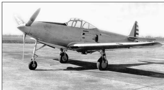
**Прототип одномоторного истребителя «Белл» P-39, создававшегося параллельно с двухмоторным «Лайтнингом»**
