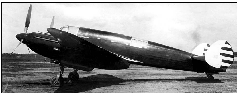
Прототип ближнего бомбардировщика А.С. Яковлева — самолет № 22 отличался очень чистыми аэродинамическими формами
