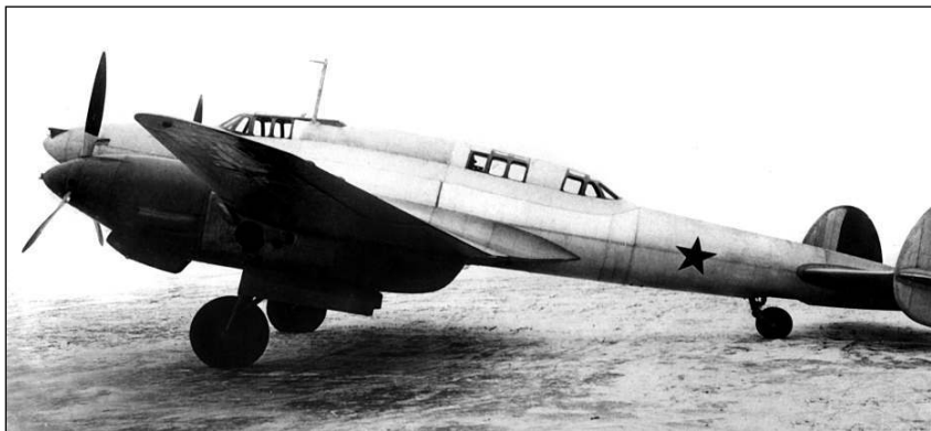
Прототип Пе-2 — высотный истребитель «100». Двигатели М-105 оснащены турбокомпрессорами, кабины экипажа герметичные, в носу фюзеляжа — два пулемета ШКАС и две пушки ШВАК
