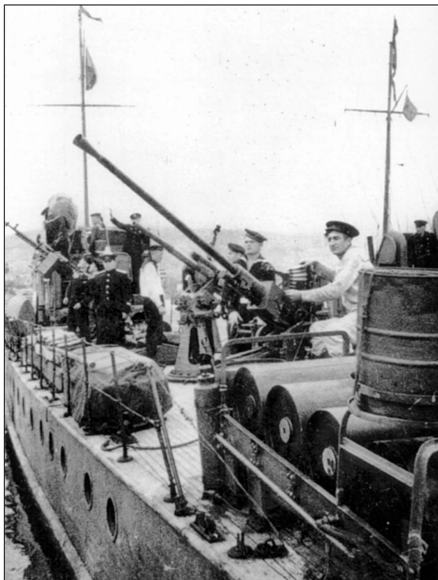
Кормовой бомбосбрасыватель с глубинными бомбами ББ-1 на одном из малых охотников. Артиллерийское вооружение катера усилено 25-мм автоматом за счет демонтажа стеллажа с глубинными бомбами
