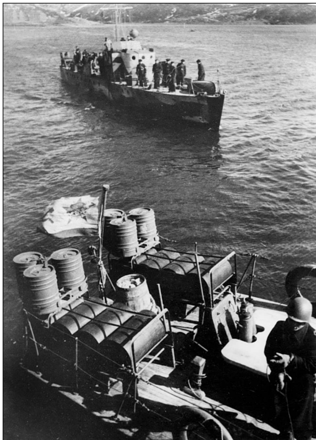
Вверху: дымовые шашки МДШ на одном из катеров типа МО Северного флота. Хорошо видны бомбосбрасыватели с ГБ ББ-1 Внизу: постановка дымовой завесы катером типа МО
