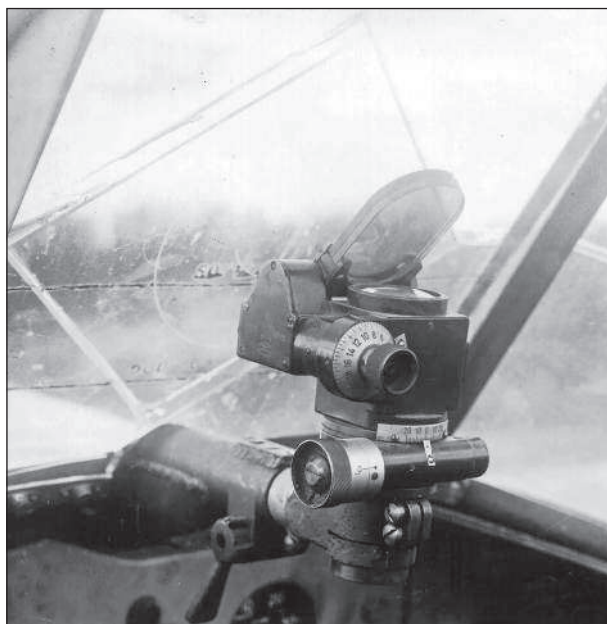
Размещение оптического прицела ПБ-1 на самолете Ил-2. С августа 1942 г. был заменен простейшим механическим прицелом ВВ-1 конструкции Васильева.
