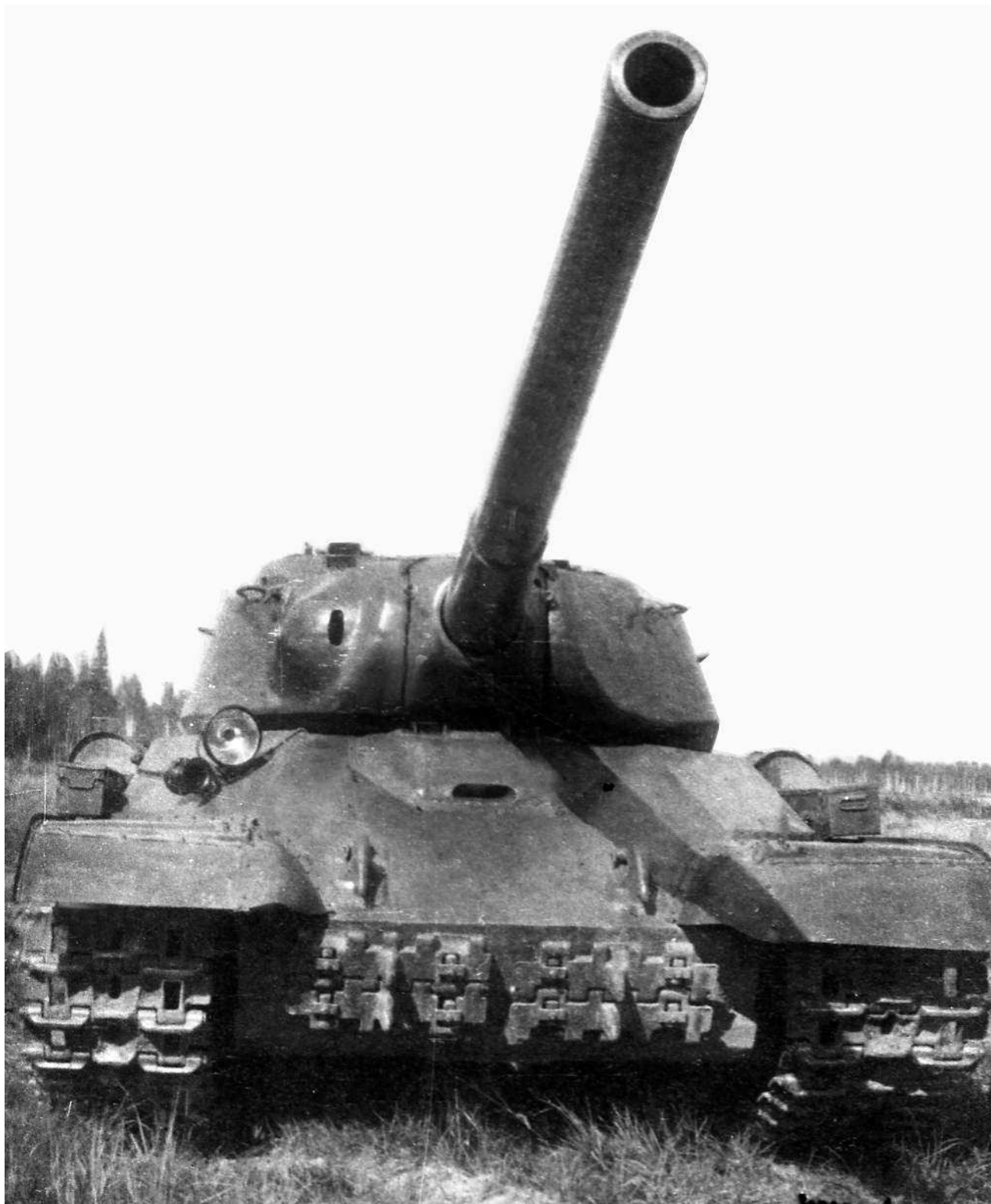
Опытный образец танка «объект 701» № 0 на полигоне во время испытаний 122-мм пушки С-34, вид спереди. Лето 1944 года (АСКМ).
